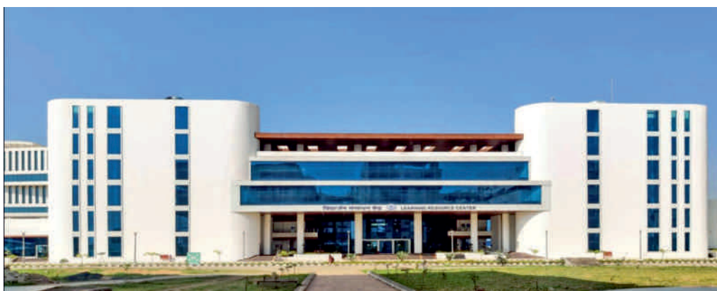
चित्र 1. लर्निंग रिसोर्स सेंटर (एलआरसी) भवन
